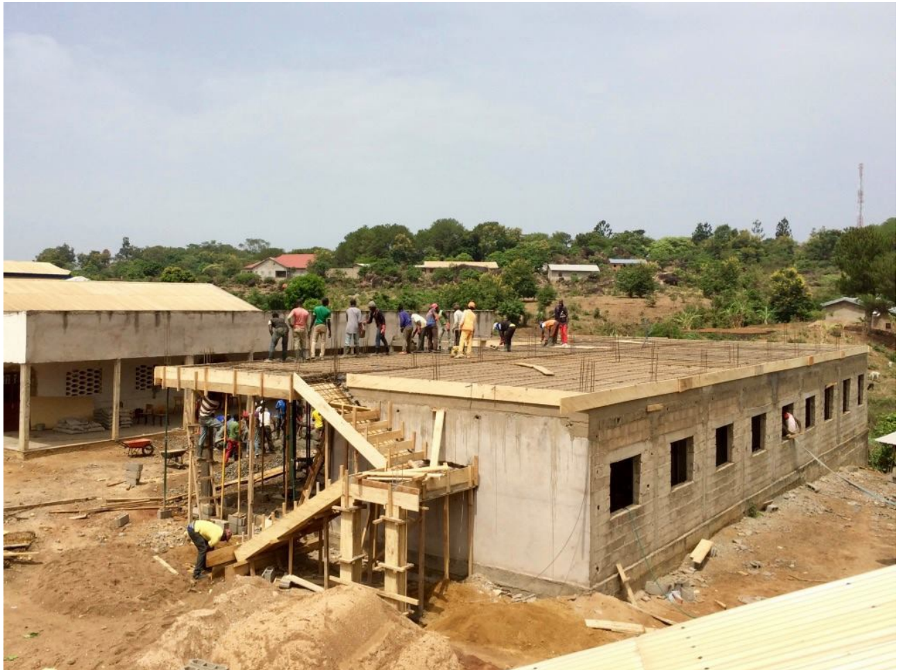
Aktuelles Foto vom Bau der Schule auf dem Grundstück des Rainbow Children's Fund in Ngaoundéré
