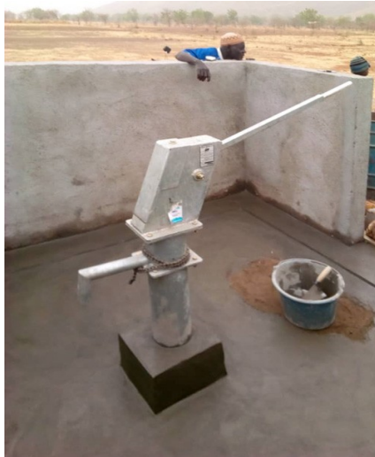
Das „Brunnenzimmer“ kurz vor der Fertigstellung
